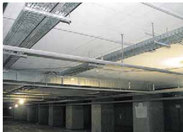
Монтаж спринклерных систем пожаротушения
