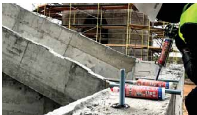
Монтаж ограждающих конструкций
