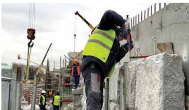
Монтаж ограждающих конструкций
