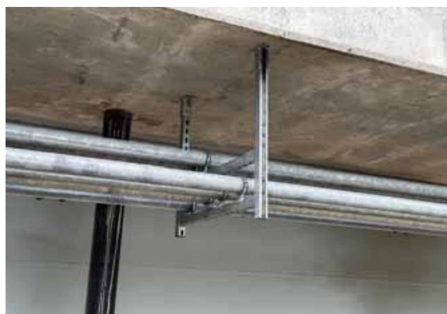
Монтаж кабельной канализации
