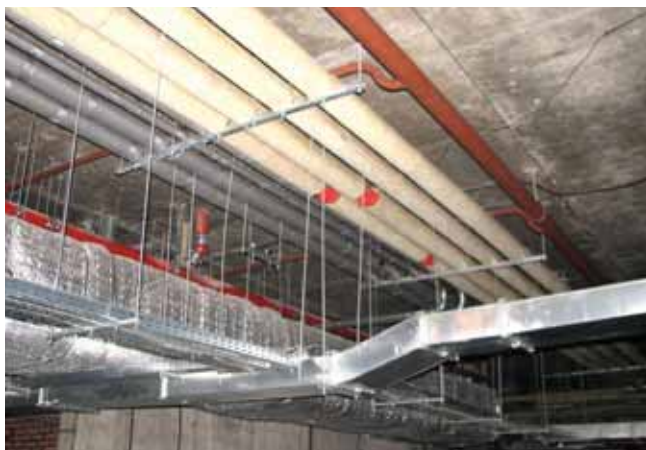
Монтаж инженерных систем
