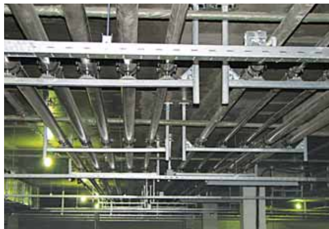
Монтаж инженерных систем
