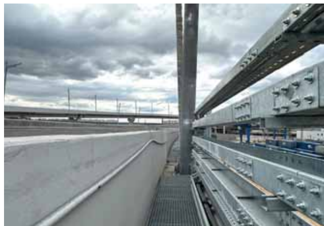
Монтаж кабеленесущих систем
