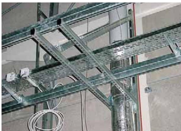
Монтаж инженерных систем
