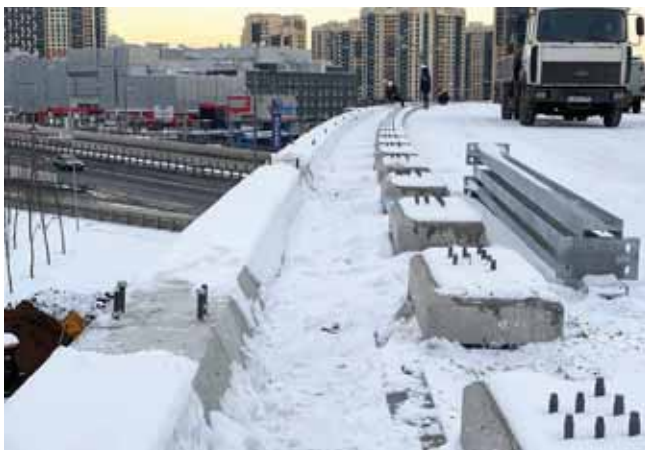
Монтаж акустических экранов
