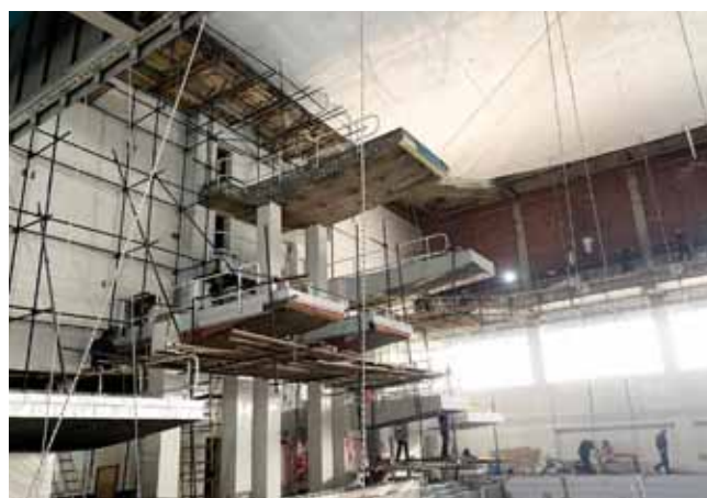
Монтаж инженерных систем бассейна
