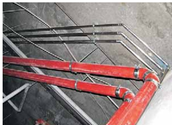
Монтаж тяжелых инженерных систем
