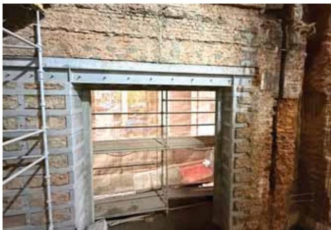
Усиление кирпичной кладки
