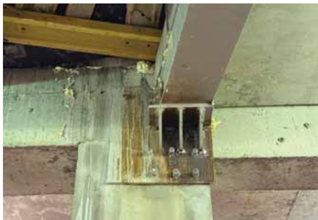
Монтаж опорного столика
