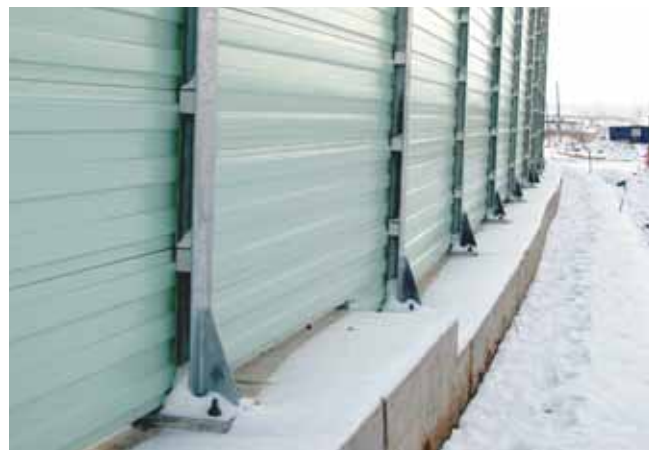
Монтаж акустических экранов
