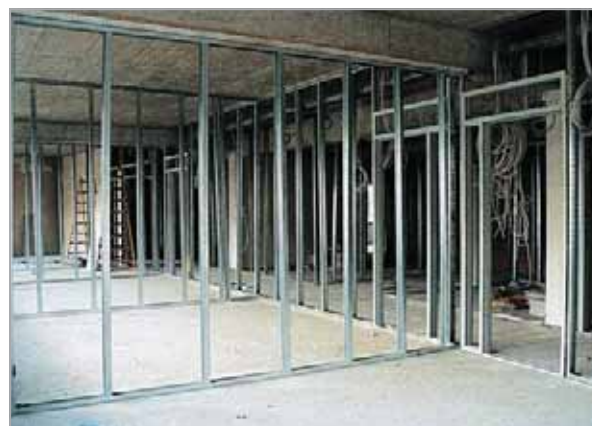
Монтаж профиля для внутренних перегородок
