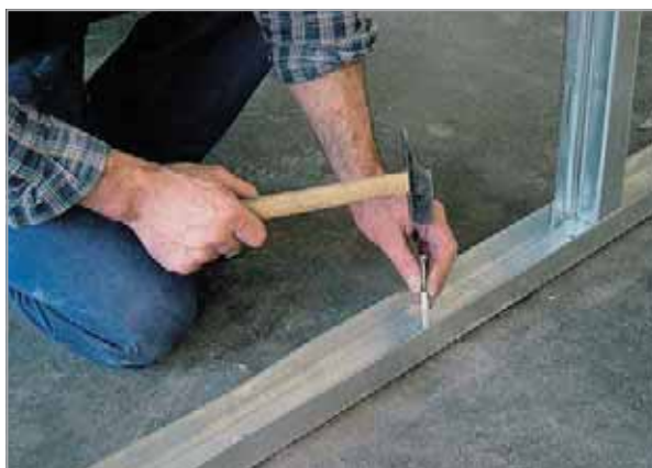
Монтаж профиля для гипсокартона
