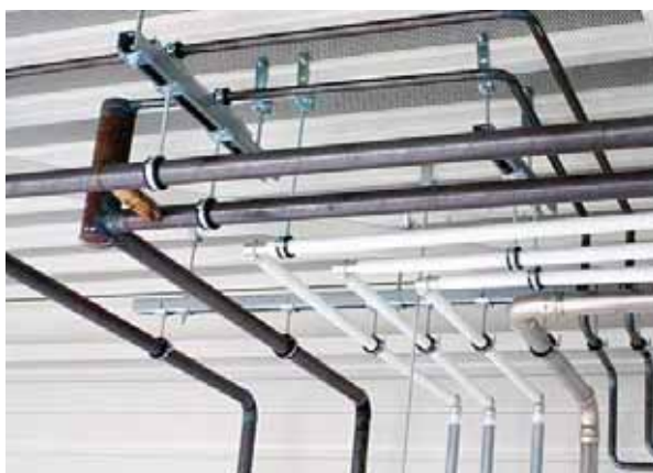
Монтаж инженерных систем к профнастилу
