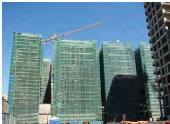
Монтаж строительных лесов
