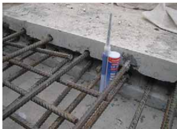
Монтаж арматурных выпусков
