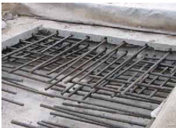
Монтаж арматурных выпусков
